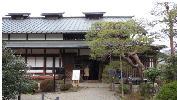
会場の主屋は明治初期に建てられ、 国の登録有形文化財。
